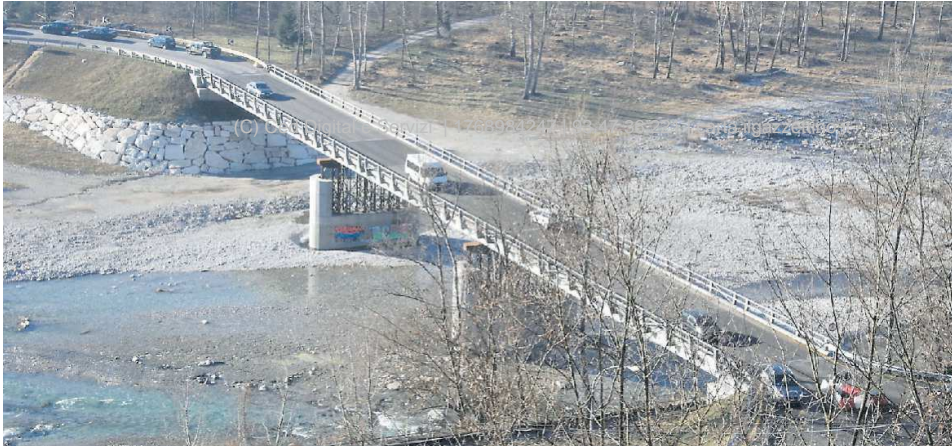
A LAMBIO il ponte Bailey, installato nel 2007 come struttura provvisoria, è stato prorogato a tutto il 2027
